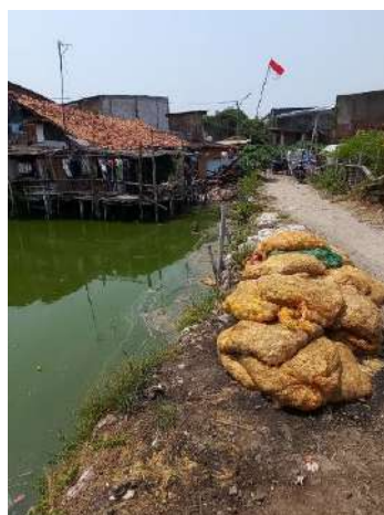
Gambar 3.2.1.54 Pintu air di inlet Embung Kampung Apung
