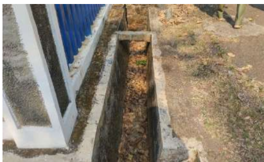
Gambar 3.2.4.48 Kondisi inlet Waduk Puspom AU (Pintu air ditutup, tidak ada aliran (debit))
