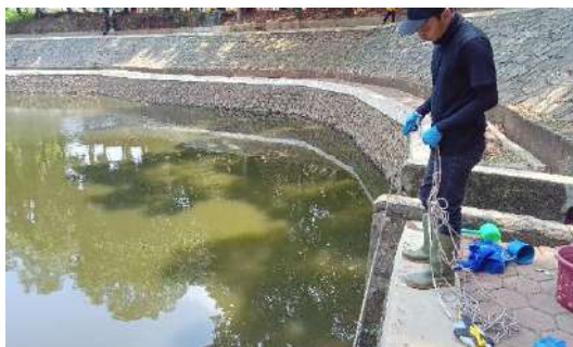
Gambar 3.2.3.33 Kondisi inlet di Situ Walikota Jakarta Selatan (tidak ada aliran)
