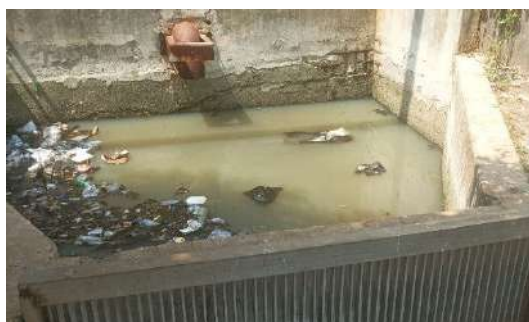
Gambar 3.2.5.77 Kondisi inlet Waduk Arboretum
