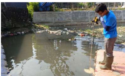
Gambar 3.2.4.88 Kondisi inlet Situ Ria-Rio (tidak ada aliran (debit))
