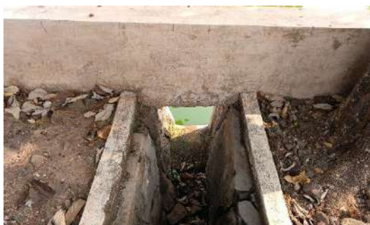
Gambar 3.2.3.76 Kondisi inlet Situ Sigura-Gura
