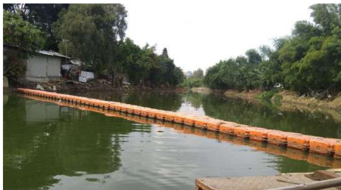
Gambar 4.3 Sekat sampah yang mengapung pada inlet Situ Ria Rio
