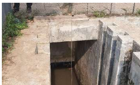
Gambar 3.2.3.94 Kondisi inlet Waduk Lebak Bulus
