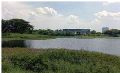
Gambar 3.2.4.101. Waduk Pacuan Kuda tidak memiliki saluran inlet
