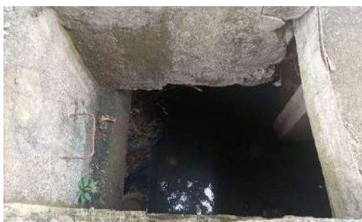
Gambar 3.2.3.70 Kondisi inlet Situ TMP Kalibata (tidak ada aliran)
