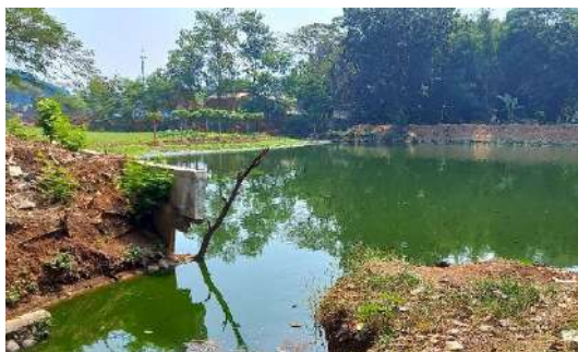
Gambar 3.2.4.76 Kondisi inlet Situ Rawa Gelam (tidak ada aliran (debit))
