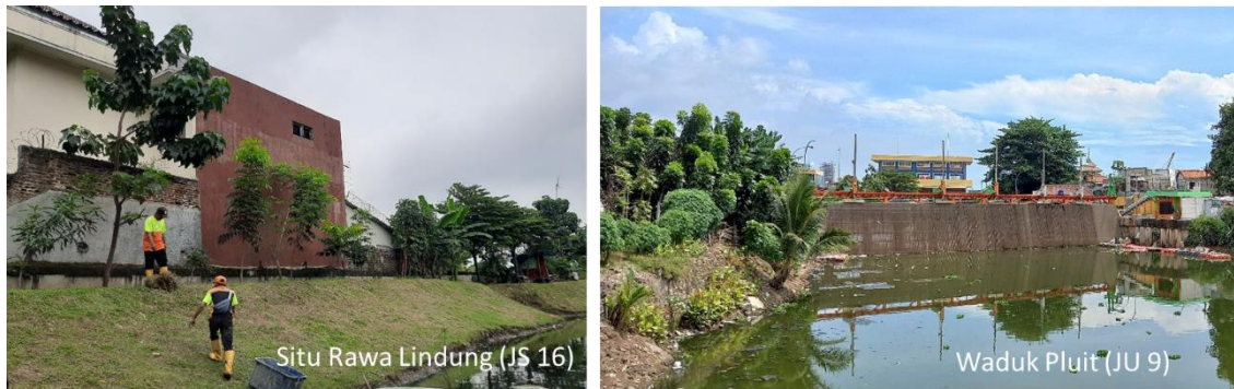
Gambar 4.7 Turap di Situ Rawa Lindung Berupa Tanah dan Waduk Pluit yang Ditumbuhi Tanaman
