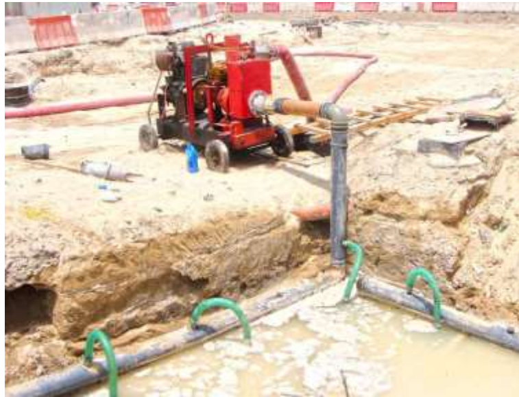
Gambar IV- 32 Contoh Dewatering
