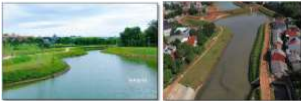
Gambar IV-12 Pembangunan Waduk Lebak Bulus dan Pembangunan Waduk Brigif
