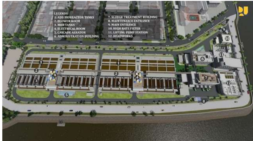
Gambar IV- 31 Rancangan Pembangunan Sistem Pengolahan Air Limbah Domestik
