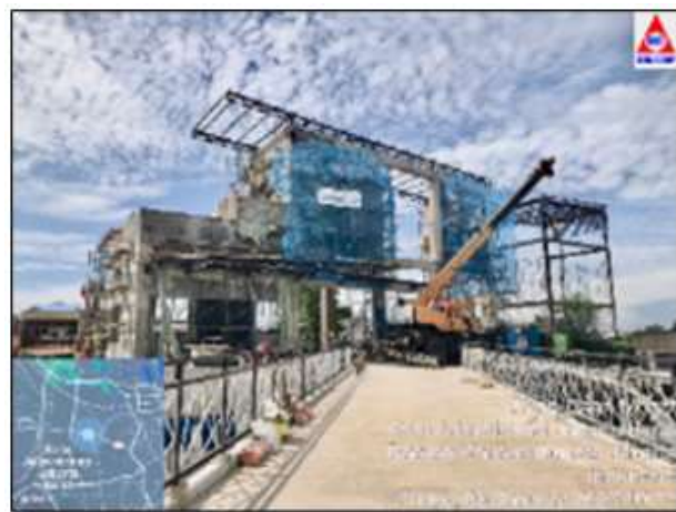
Gambar IV-10 Pembangunan Polder Pulomas dan Polder Green Garden
