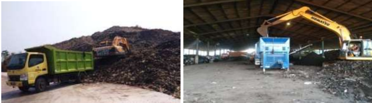
Gambar II-104 Penambangan Sampah (kiri) dan Proses Pengolahan Sampah dari Kegiatan Landfill Mining
