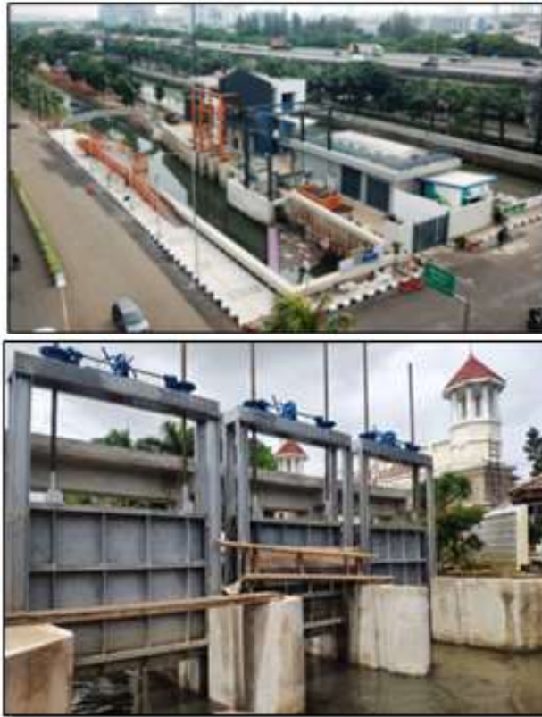
Gambar IV-9 Pembangunan Polder Kelapa Gading
