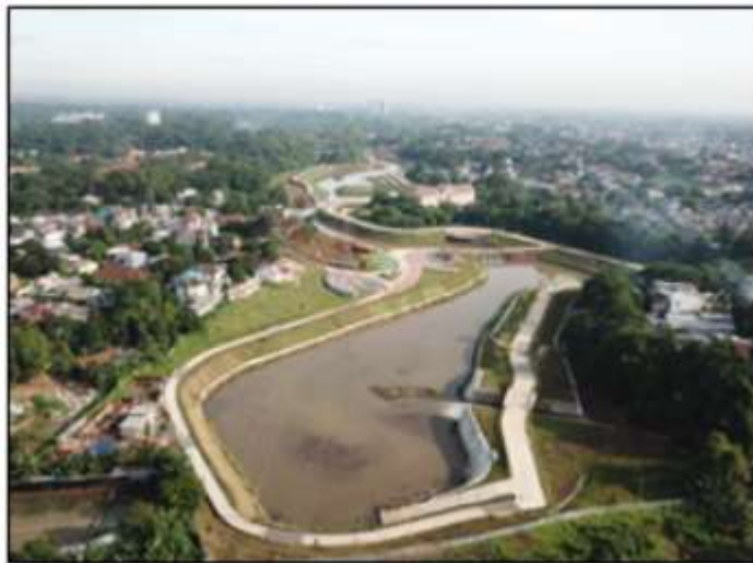
Gambar IV-13 Pembangunan Waduk Pondok Ranggan
