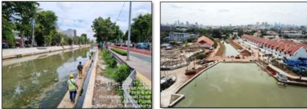
Gambar IV-14 Pembangunan/Peningkatan Kapasitas Sungai/Kali Ciliwung Hilir Kawasan Pasar Baru dan Pembangunan Sodetan Museum Bahari
