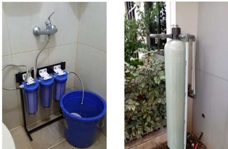
Gambar 53 Contoh instalasi unit filtrasi skala rumahan
