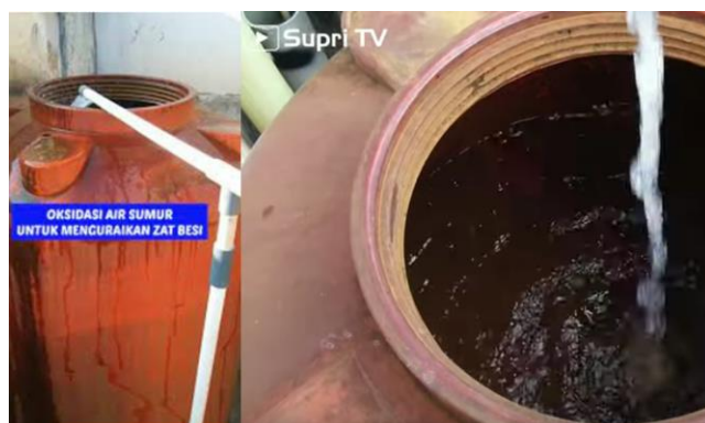
Gambar 54 Contoh instalasi unit oksidasi-filtrasi skala rumahan
