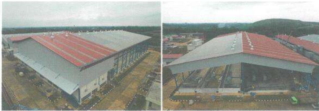
Hanggar Utama RDF Plant
