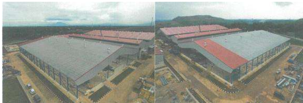
Hanggar Utama Landfill Mining
