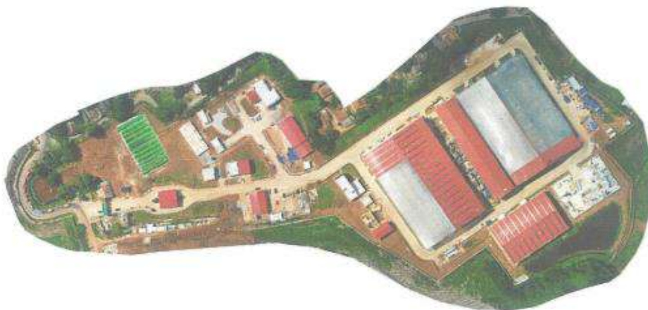
Foto Udara Area Proyek Pembangunan Fasilitas Landfill Mining dan RDF Plant
