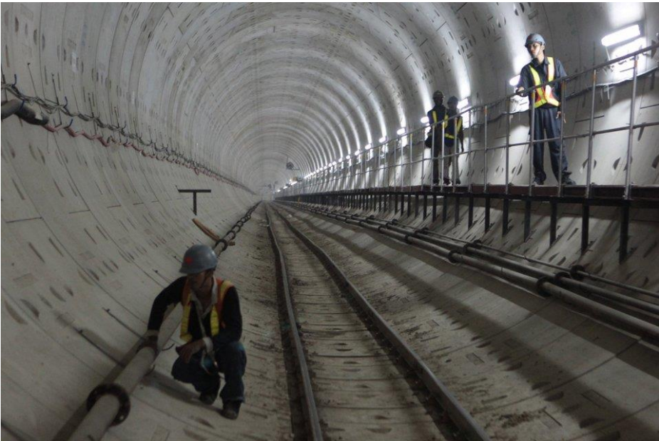
Gambar 3-43. Progress Pembangunan Mass Rapid Transit (MRT) Jakarta
