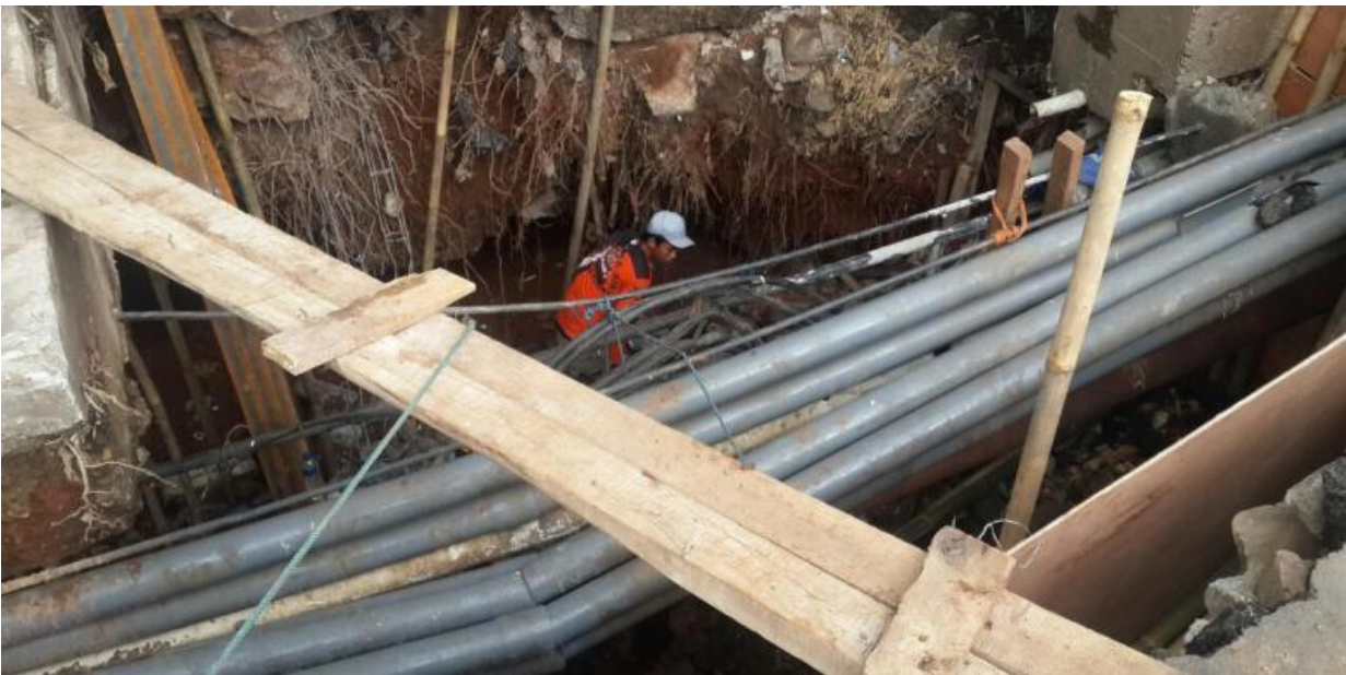
Gambar 3-10. Perbaikan Drainase Bocor Yang Menyebabkan Jalan Sudirman Ambblas
