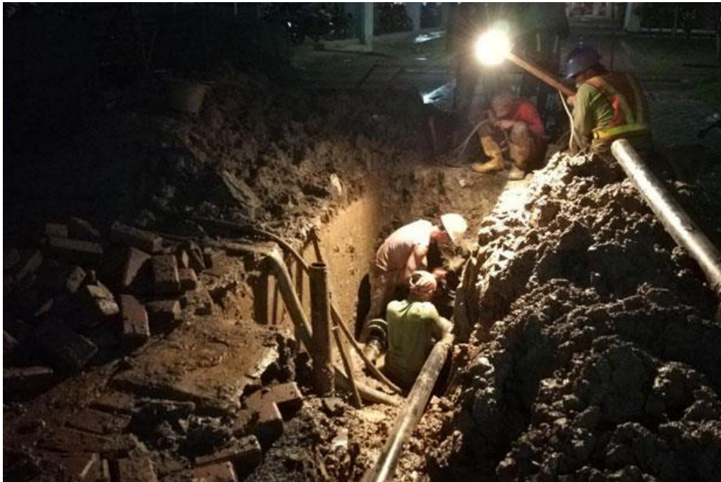
Gambar 3-19. Pembangunan Pipa Air Bersih ke Rusunawa di Jakarta Barat
