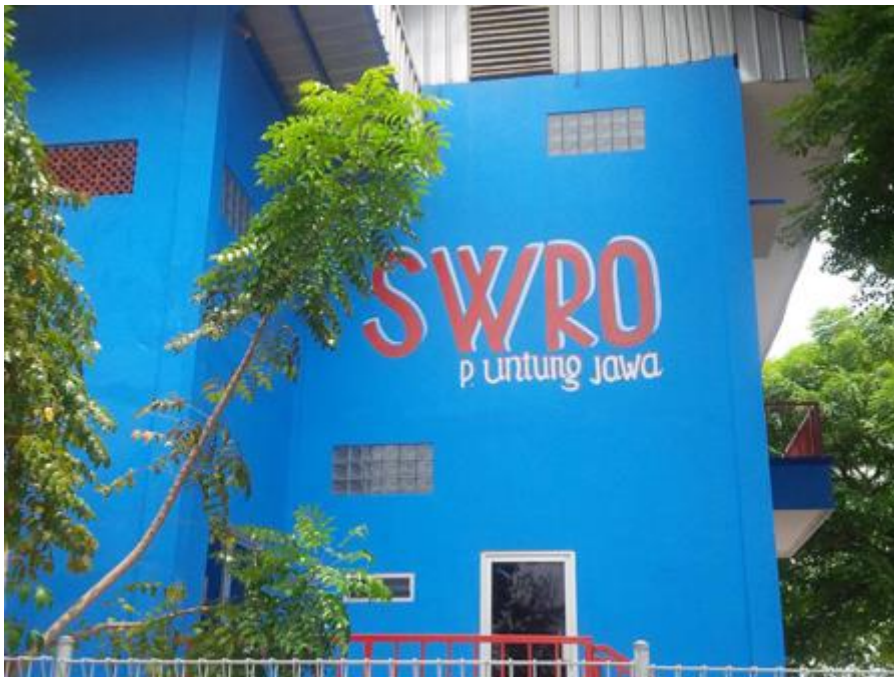
Gambar 3-20. Gedung untuk Sea Water Reversed Osmosis (SWRO) di Pulau Untung Jawa, Kepulauan Seribu
