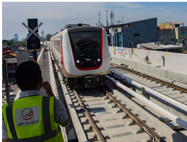
Gambar IV.9 Progres Pembangunan LRT Jakarta
